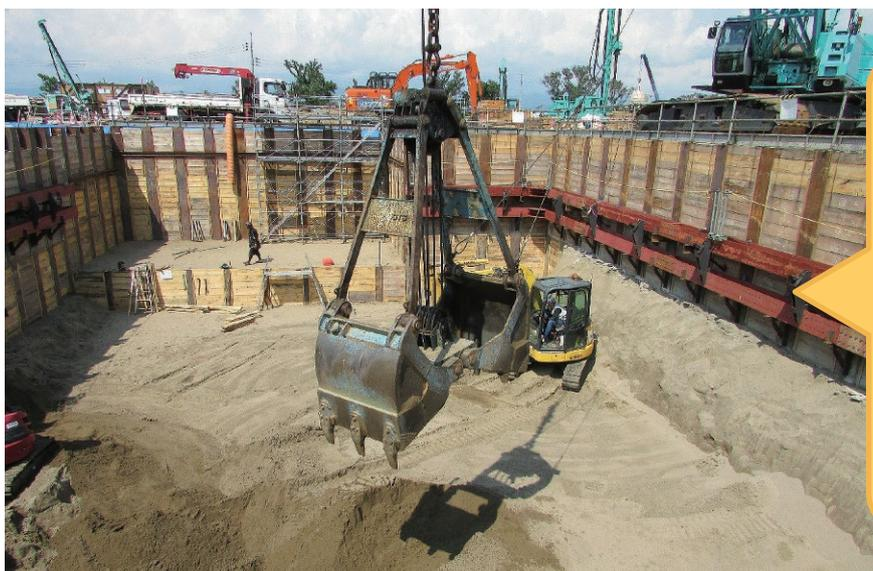
収集した可燃ごみを貯めておく「ごみピット」を作るため、掘削を進めています。掘削には貝殻のような形をした鋼製の「クラムシェルバケット」を使用し、1回で約1m<sup>3</sup>の土を掘り上げています。
